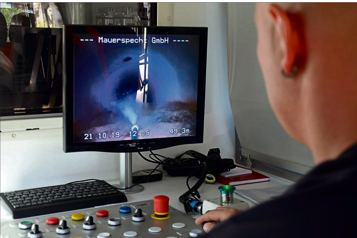
Maik Kröner von der Mauerspecht GmbH steuert per Joystick den Roboter, der die Reißenbachdohle vom Kalk befreit. Das Unternehmen aus Coswig bei Dresden bietet bundesweit als einziges die Verbindung zwischen der Hochdruckstrahl- und Robotertechnik an. FOTOS: SAUTTER
