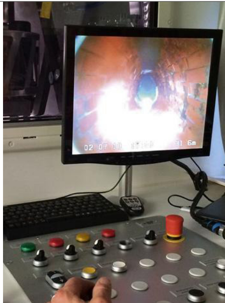
Erster Einsatz der hauseigenen HD-Roboter von Mauerspecht bei Hamburg Wasser (2018) | Foto: Mauerspecht
