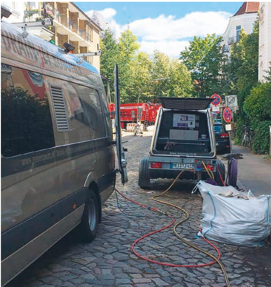
Bild 1: Baustelleneinrichtung bestehend aus Bedienfahrzeug, Höchstdruckpumpe und Saug-/Spülwagen
