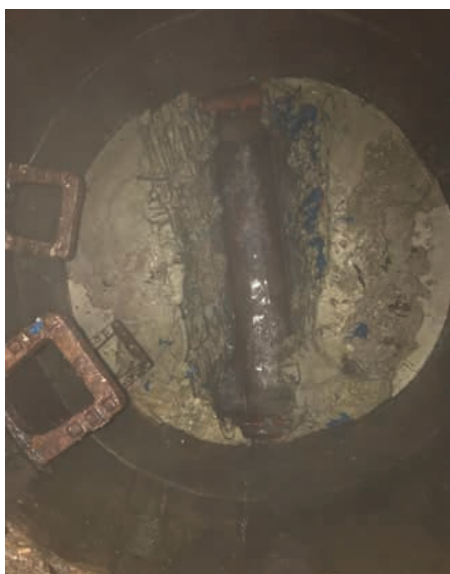
Beton im Kanal
