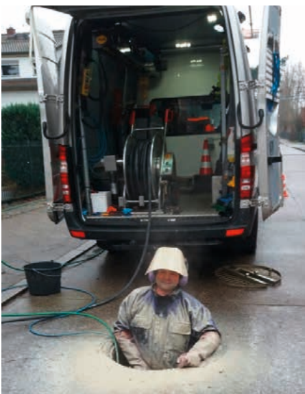
Voller Körpereinsatz: Mit ihrer Drain-Jet Robotics-Technologie hat das Unternehmen Mauerspecht beim Havarie-Einsatz in Berlin umgehend helfen können.
