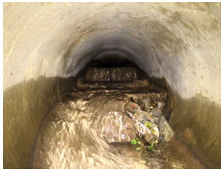
Entfernen von Kalkablagerungen (70% Verschluss) aus Betonrohr DN 300 (vorher, nachher) | Fotos: Mauerspecht
