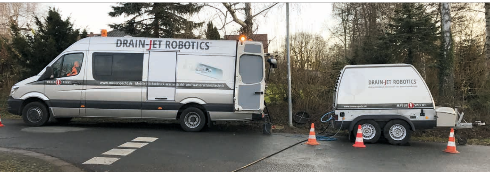
Baustelleneinrichtung mit Bedienfahrzeug und Wasser-Hochdruckpumpe
